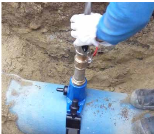
Регенсбург / Германия 150 VAG TERRA ® lock Врезных хомутов
