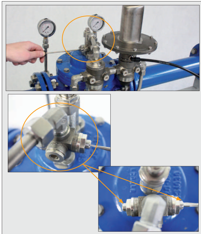
Рис. 32: Настройка скорости открытия и закрытия
