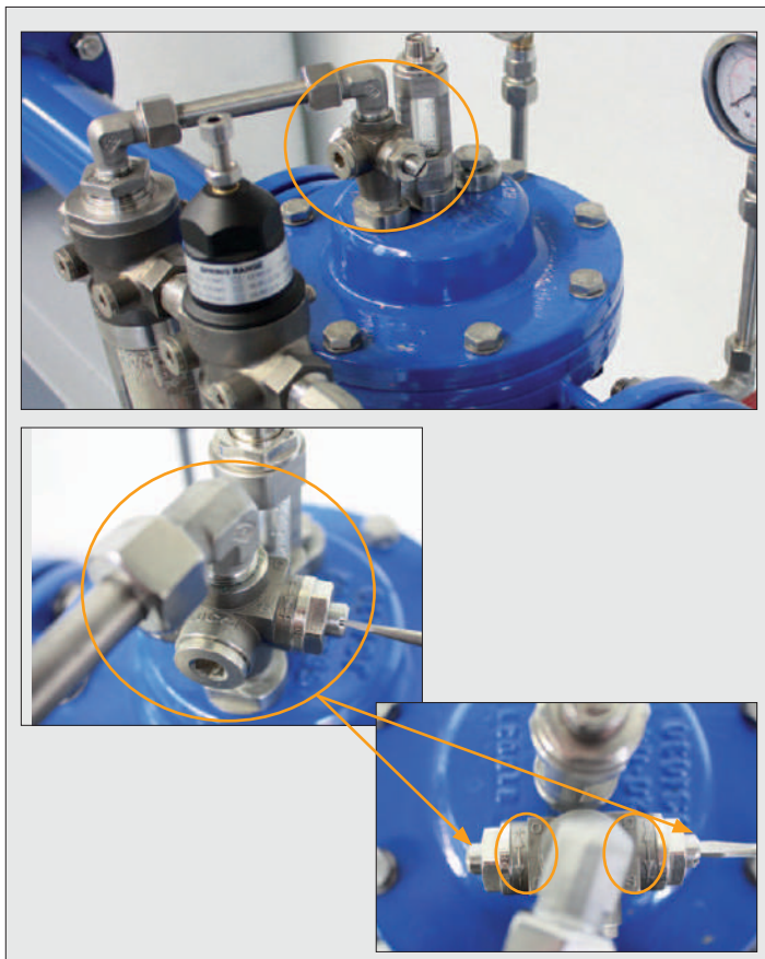
Рис. 8: Настройка скорости открытия и закрытия
