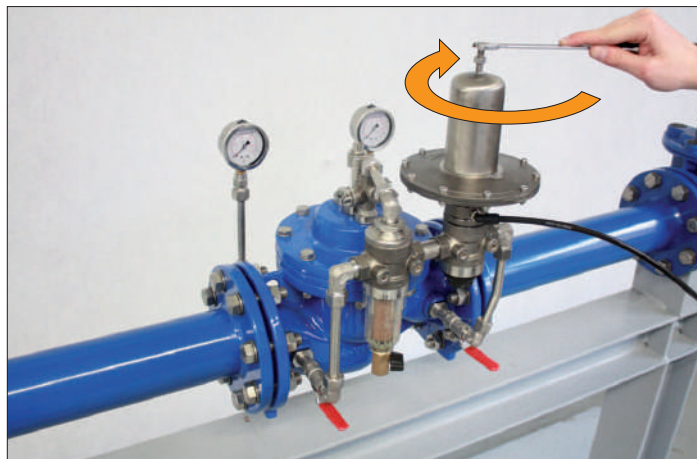
Рис. 37: Задание нужного уровня заполнения резервуара
