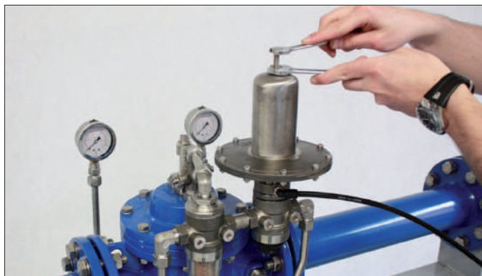
Рис. 38: Фиксация регулировочного винта
