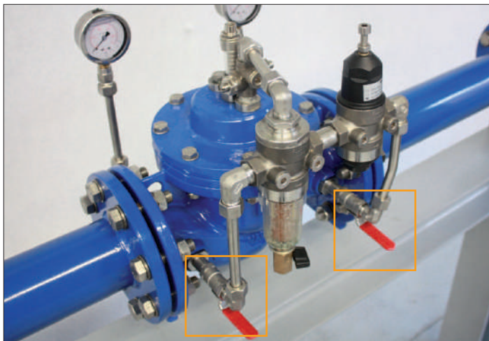
Рис. 7: Открытые шаровые краны - рычаги параллельны трубкам контура управления
