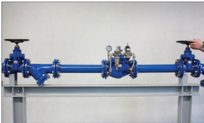
Рис. 12: Полное открытие арматуры перед РК и частичное открытие арматуры после РК
