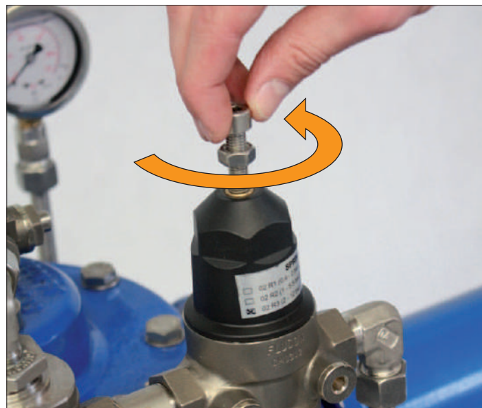
Рис. 6: Ослабление пружины
