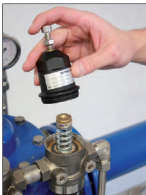
Рис. 44: Снятие пружины и пружинной шайбы
