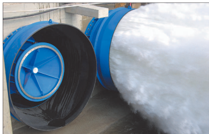
Рис. 3: VAG KSS с кожухом и встроенной аэрацией
