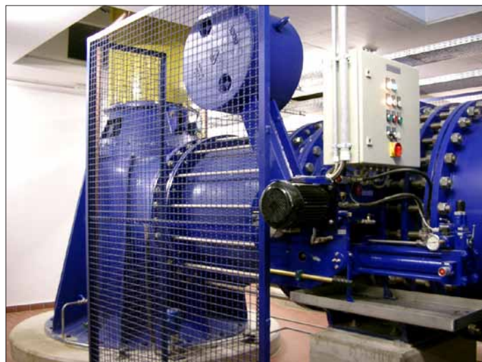
Рис. 1: Пример защитных мер на предприятии (сетка, защищающая оператора от падающего груза)
